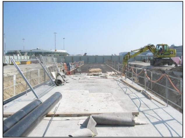
Les travaux se sont déroulés par étapes avec le trafic des avions à proximité. Importants travaux de l'étanchéité ont été réalisés sur les parties du bâtiment en sous-sol ainsi que sur le tunnel de liaison, sur laquelle ont été coulées les dalles du tarmac. La responsabilité des travaux d'étanchéité a été assumée par le bureau d'ingénieurs civils.
