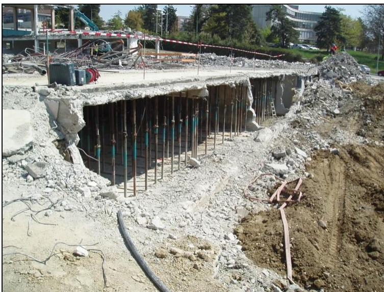
Transformation du sous-sol du bâtiment existant
