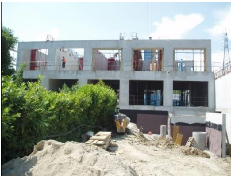
Bâtiment technique en construction
