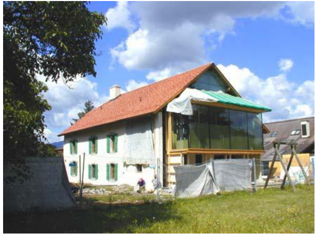
Bâtiment avec nouvelle salle du conseil
