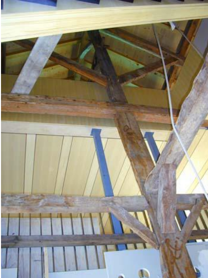
Nouveau plancher avec ancienne structure partiellement conservée
