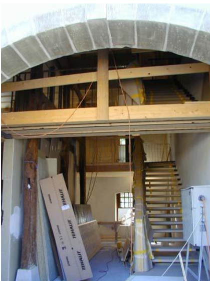
Phases de chantier
