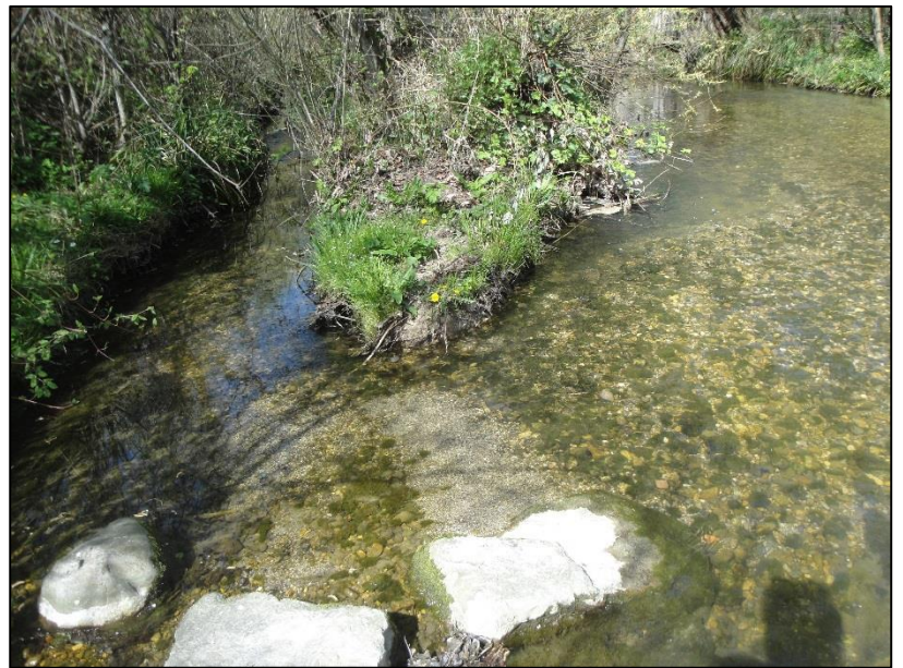
Entrée bief de migration et digue végétalisée.
