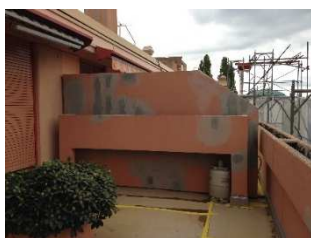
Traitement de la carbonatation
