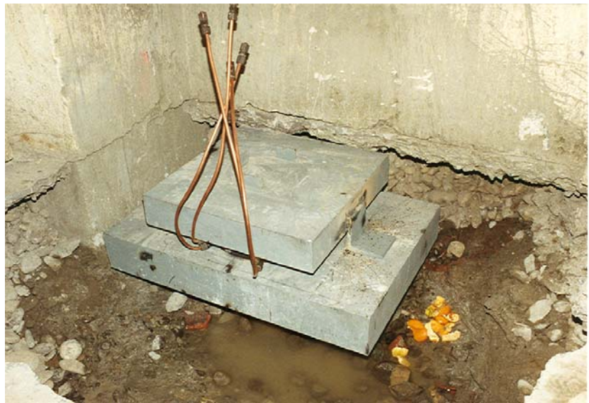
Plaque de tête des pieux, vérins plats pour mise en charge de la structure et plaque d'appui du pilier
