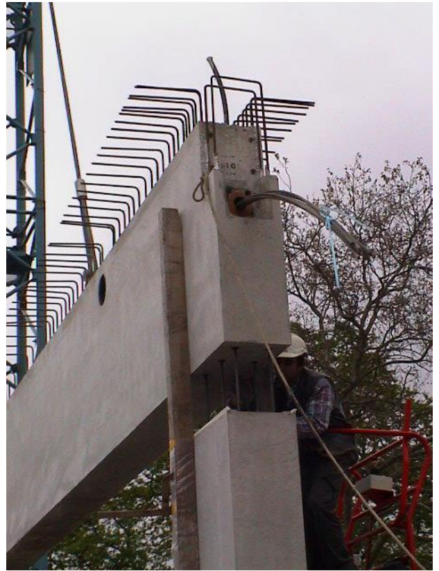
Pose poutre préfabriquée salle de gym
